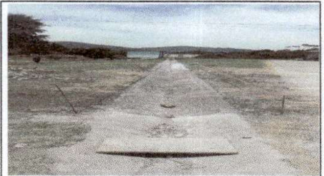
Foto 2: Cuneta ya reparada
