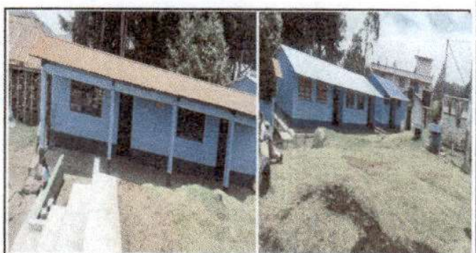
Foto 6: Pintura en muro ya finalizado
