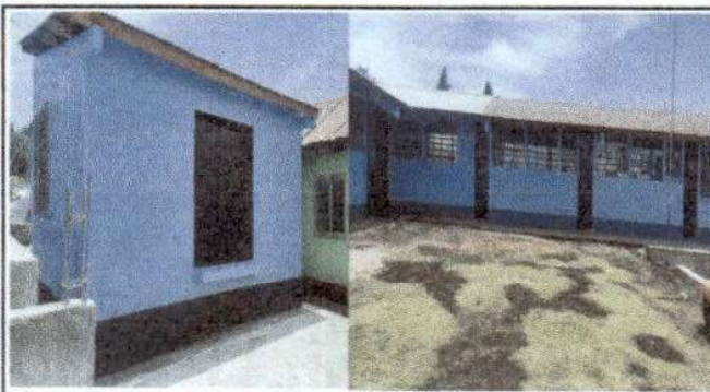
Foto 3: Pintura en muro ya finalizado
