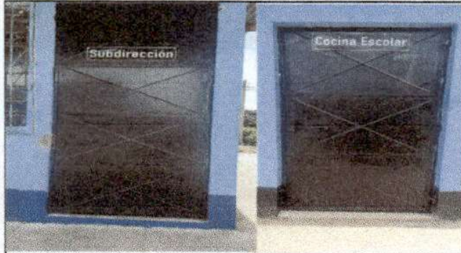
Foto1: Las puertas ya construidas e instaladas
