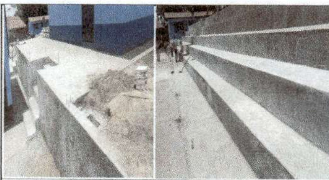
Foto 5: Remoción de gradas ya finalizado
