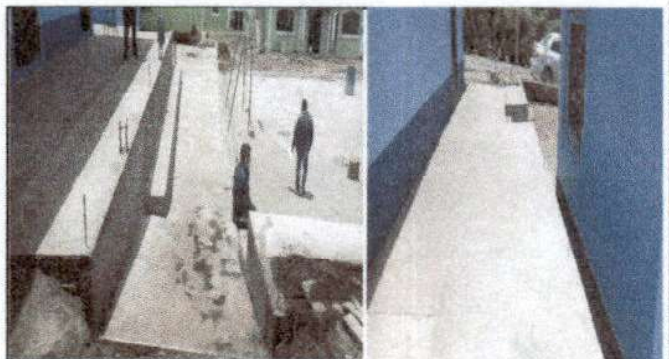
Foto 4: Plancha ya finalizada
